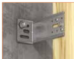
En rive de bâtiment, l'espacement entre les équerres est réduit (0,90 m) et les équerres sont toutes placées du même côté sur le chevron d'extrémité (voir schémas).
